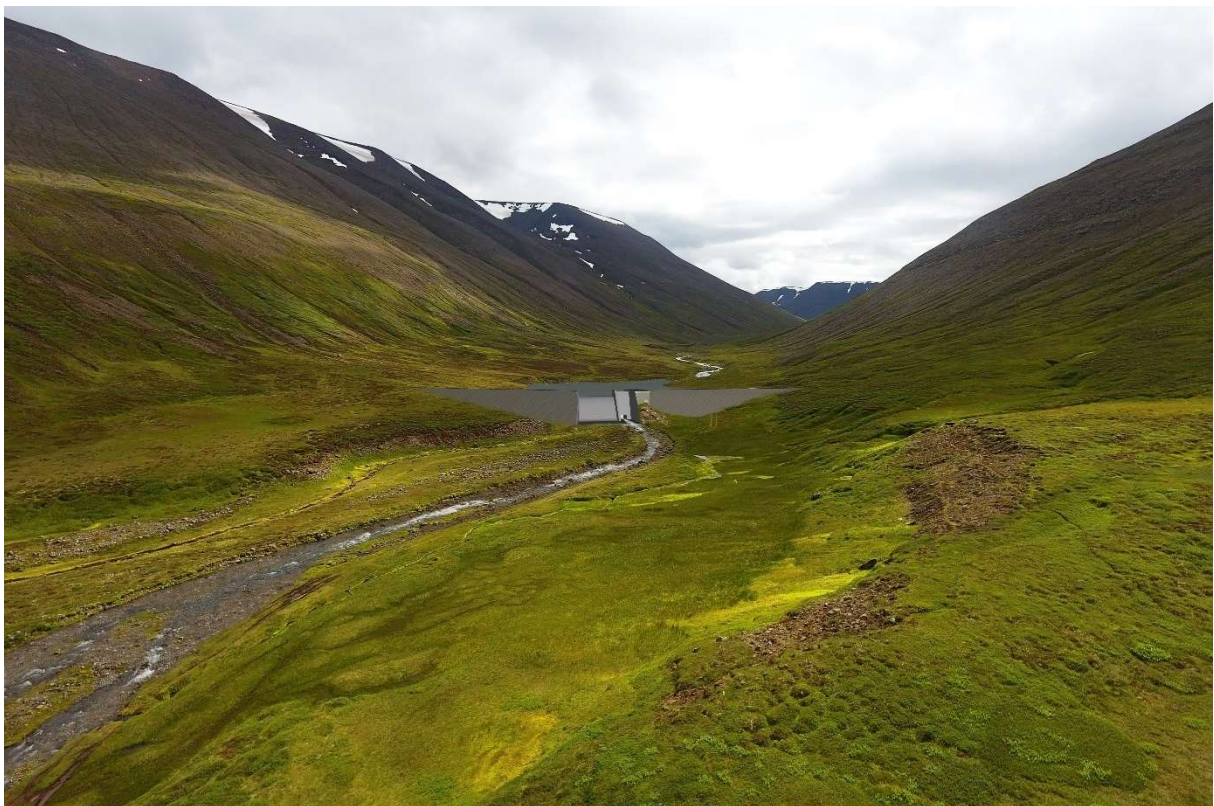
MYND 4.29 Séð inn Hólsdal að sumarlagi eftir framkvæmdir. Á myndinni má sjá fyrirhugaða stíflu og inntakslón í yfirfallshæð. Á myndina vantar vegslóð að stíflu. Nærmynd af stíflu má sjá á mynd 2.4.
