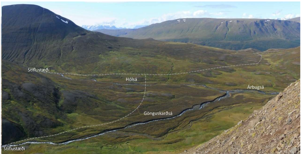
MYND 2.14 Framkvæmdasvæði á Hólsdal og Gönguskarði. Pípuleið er dregin inn á myndina með hvítri brotalínu til skýringar.
