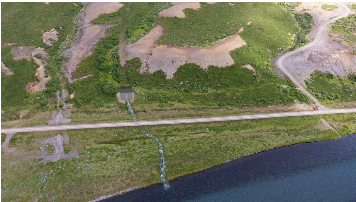
MYND 4.27 Séð yfir Fnjóskadalsveg eystri (nr. 835) og stöðvarhús eftir framkvæmdir. Aðrennslispiþan er neðanjarðar en það sést móta fyrir raski eftir lagningu hennar. Á myndina vantar veltenginu við húsið en veltenging og gatnamót verða hönnuð í samráði við Vegagerðina. Frárennisskurður fer í ræsi undir veg nr. 835.
