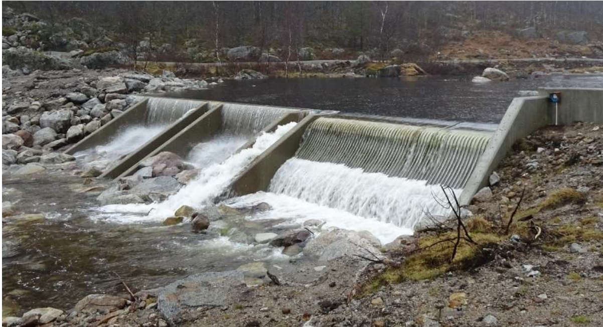
MYND 2.7 Ljósmynd af Coanda-inntaki og yfirfalli sambærilegu því sem áætlað er að nota á Gönguskarði.
